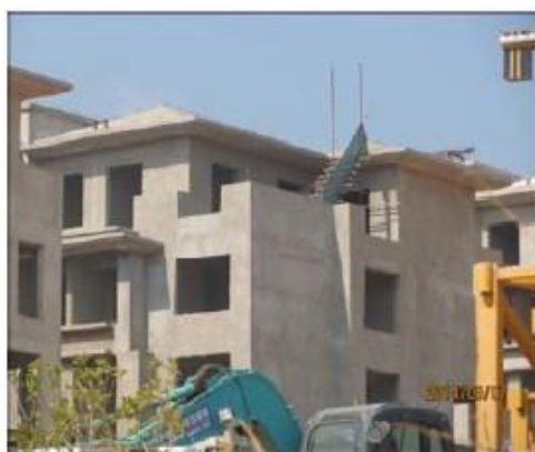
21#栋外墙抹灰施工完成
