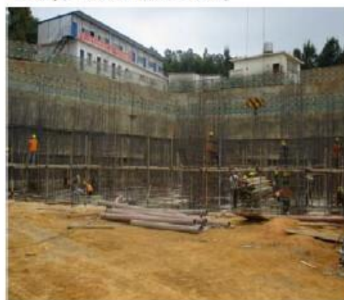
2#栋负三层结构施工完成
