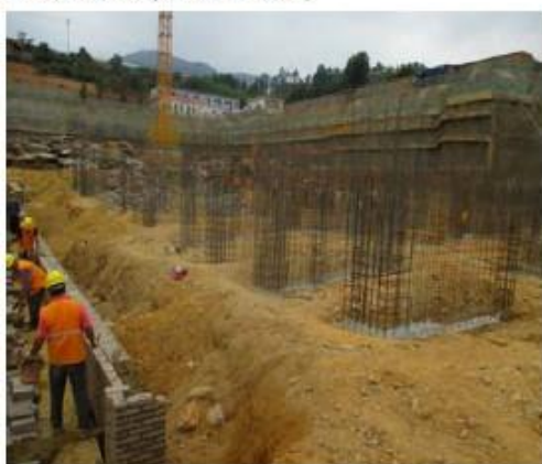
1#栋底层筏板施工完成
