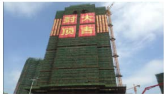
（图四：2#现场施工进度图）
