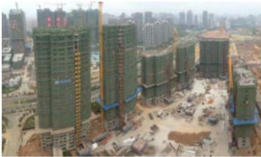
（图三：J1 地块施工全景）
