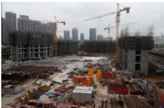
J1 地块施工全景
