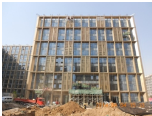
4#楼北侧玻璃安装
