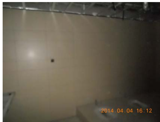
3#楼卫生间墙面瓷砖粘贴
